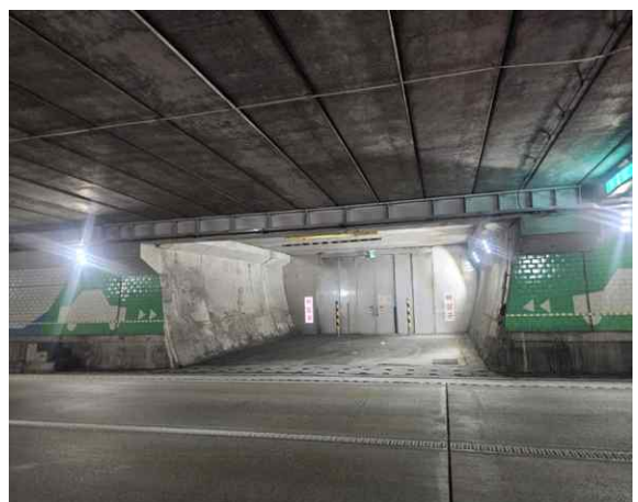
신월여의지하도로 (여의도방향) 횡갱
