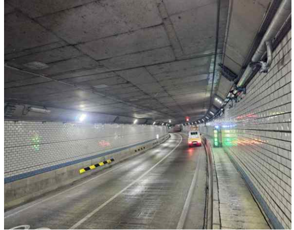
신월여의지하도로 (여의도방향) BOX구간
