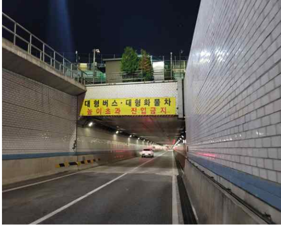
신월여의지하도로 (여의도방향) 진입부
