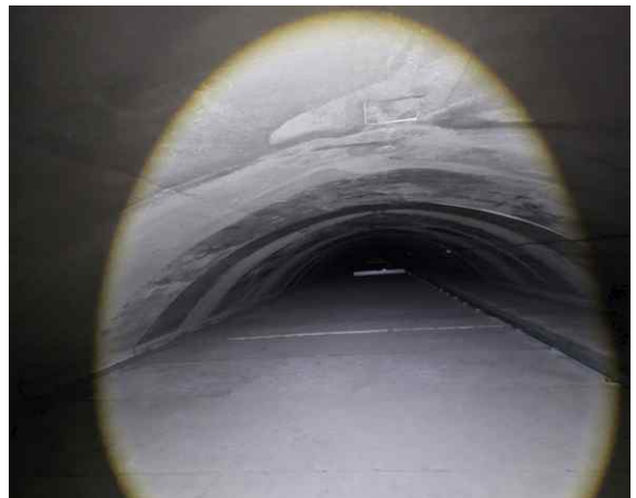
신월여의지하도로 (여의도방향) 풍도슬래브
